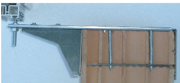
Przekrój – szyna wspomagająca + kołownik
