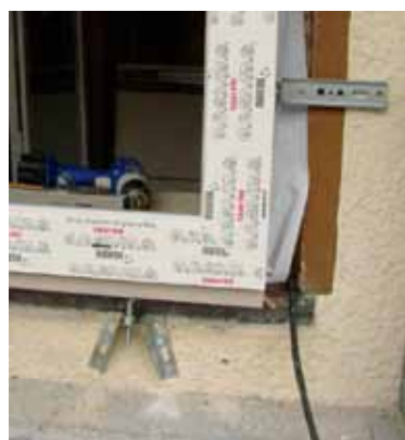
Renowacja z zastosowaniem konsol.
