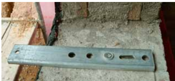
Konsola EL jako podpora dolna/nośna.
