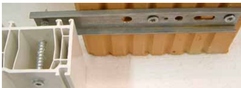
Konsola EL w formie ceownika jak konsola boczna.
