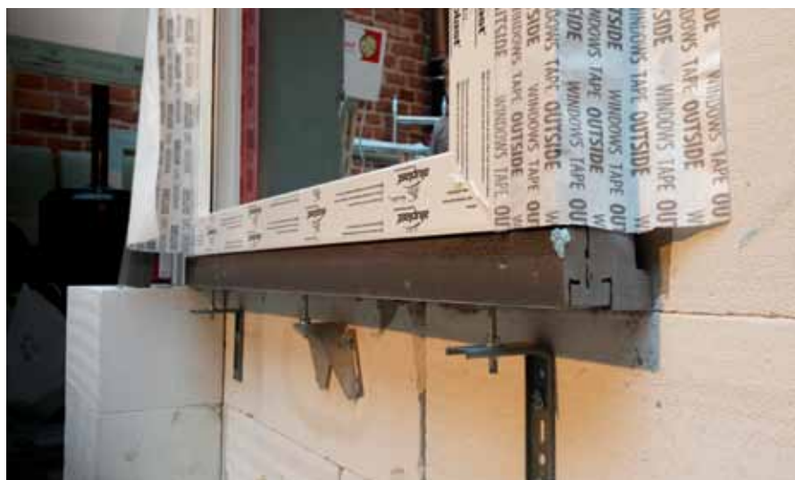
Montaż w ociepleniu na bloku podokiennym.
