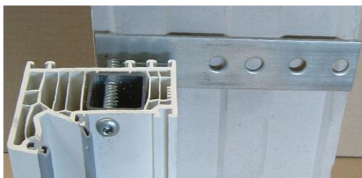
Ilustracja 12: Krok 2 - przykręcić przez futrynę okienną
