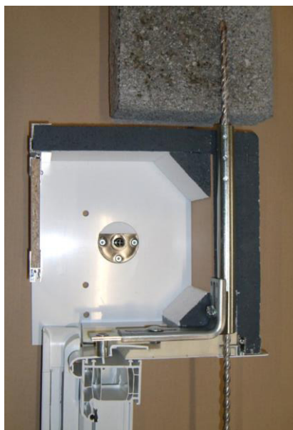
Ilustracja 115: Krok 2 - wkręcać
