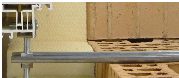
Ilustracja 16: Konsola WU poniżej - okna z plastiku
