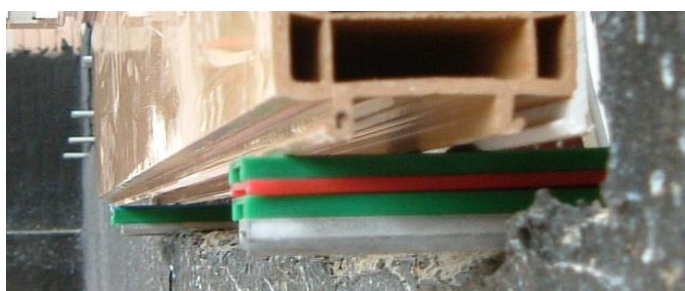
Ilustracja 4: Przykręcenie od dołu przez konsolę
