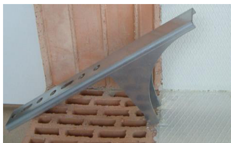
Ilustracja 41: Zaznaczyć pozycję zamocowania
