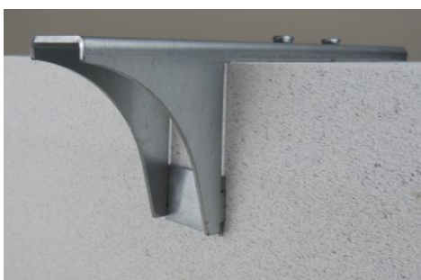
Ilustracja 48: Płyta ochronna SL w połączeniu z konsolą SL na bloku poziomnicy gazobetonowej
