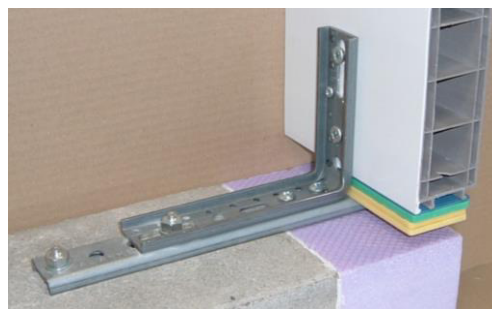
Ilustracja 55: Przykręcanie kątownika
