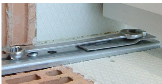
Ilustracja 45: Wyrównać okno na wysokości
