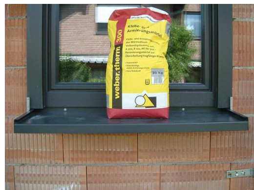
Ilustracja 94: Plac budowy: worek 30 kg - parapet wytrzymuje!
