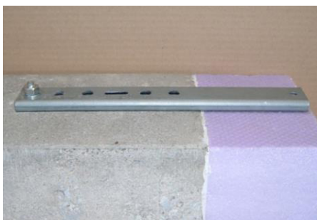
Ilustracja 53: Przywiązanie do betonowej podstawy
