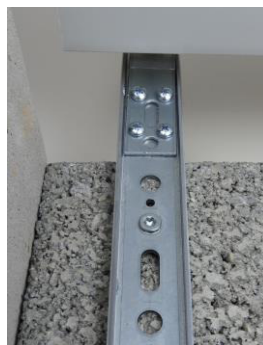
Ilustracja 66: w połączeniu z kotwą EL
