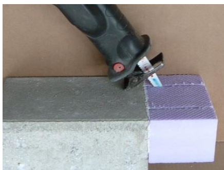
Ilustracja 58: Precyzyjnie wyciąć pozycję zamocowania
