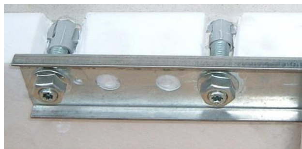
Ilustracja 133: Konsola EL z izolowanym stropem
