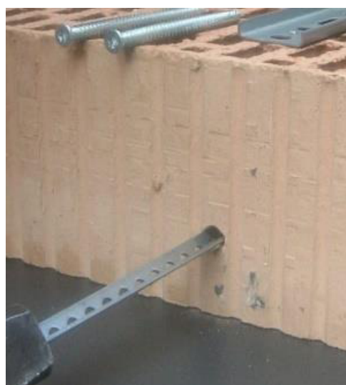
Ilustracja 29: Krok 1 – Wbić szyny perforowane w wywiercony otwór
