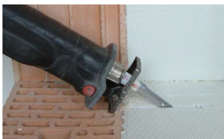
Ilustracja 42: Precyzyjnie wyciąć pozycję zamocowania, wprowadzić konsolę SL i zamocować
