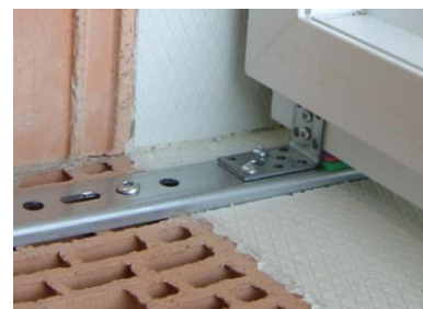
Ilustracja 43: Wyrównać okno, wykonać oklockowanie i przykręcić do konsoli za pomocą kątownika łączącego
