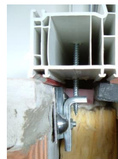
Ilustracja 88: Dolne zamocowanie okna
