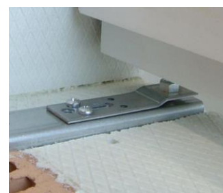
Ilustracja 46: Skręcić element regulacyjny z konsolą SL
