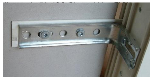
Ilustracja 79: FMW z ISO-Platte zamontowane
