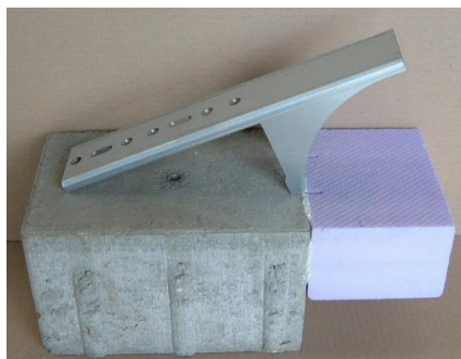
Ilustracja 57: Zaznaczyć pozycję zamocowania
