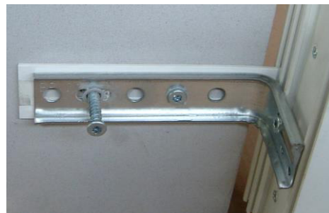
Ilustracja 82: Krok 2 - przymocować z co najmniej dwoma punktami mocującymi do muru.
