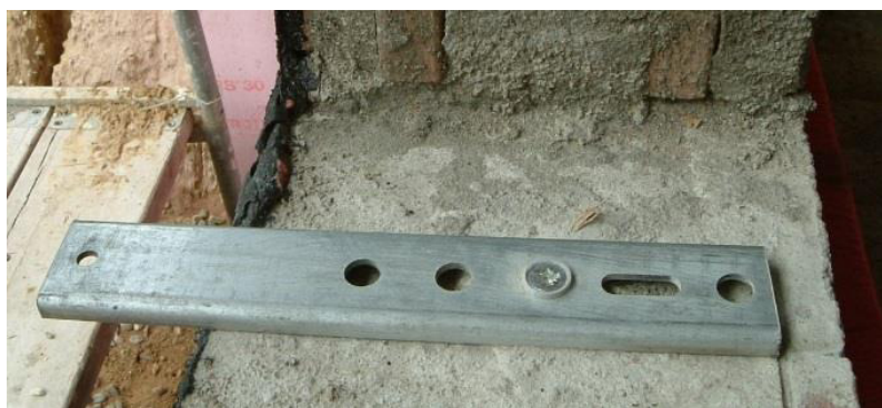
Ilustracja 3: Konsola EL jako pomoc montażowa
