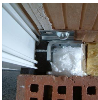
Ilustracja 87: Boczne zamocowanie okna
